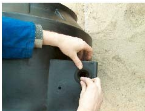
Фото № 6. Установка входной прокладки на вырезанное отверстие.
