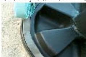
Фото № 12. Укладывание прокладки UP
