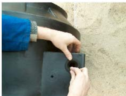
Фото № 6. Установка входной прокладки на вырезанное отверстие.
