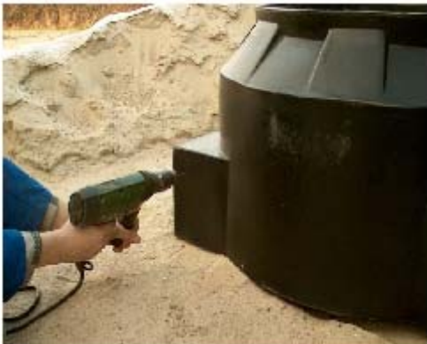
Фото №3. Сверление направляющего отверстия
