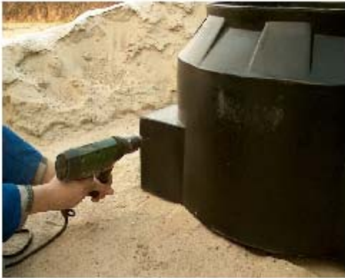
Фото №3. Сверление направляющего отверстия
