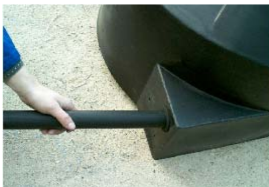
Фото № 7. Засовывание полиэтиленовой трубы в гнездо с прокладкой
